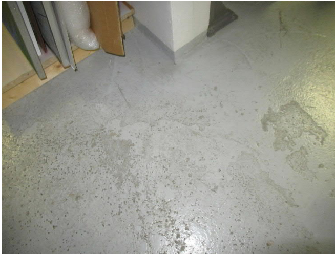
Kuva 3.6.1: Maalattujen lattioiden paikallisten maalauskorjausten arvioidaan ajoittuvan tarkastelujaksolle.
