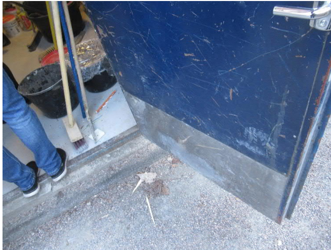
Kuva 3.4.5: Metalliset umpiulko-ovet suositellaan kunnostamaan ja pintakäsittelmään heti tarkastelujakson alussa.
